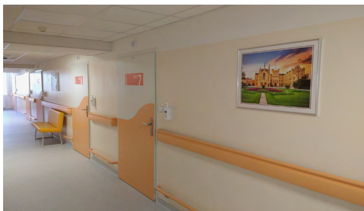
Chodba po rekonstrukci / Foto: archiv oddělení
