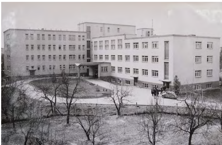
Stará budova psychiatrie před stěhováním do dolního areálu / Foto: archiv oddělení
