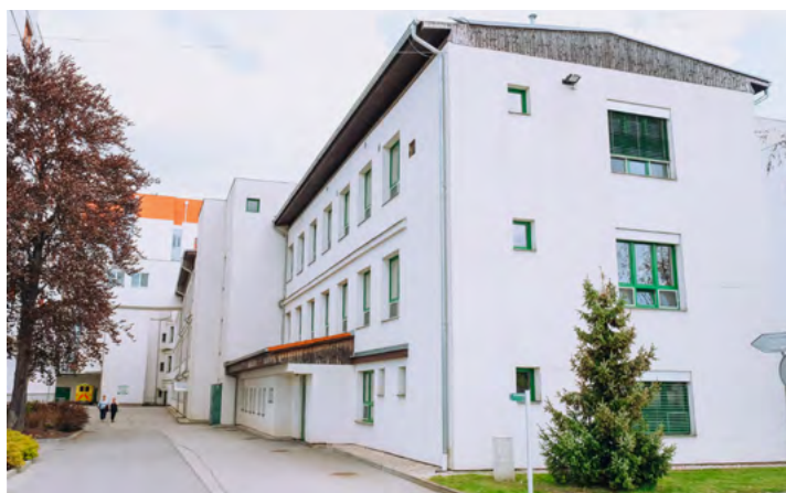
Pavilon Infekčního oddělení v roce 2022, pohled od současného zam. parkoviště / Foto: redakce
