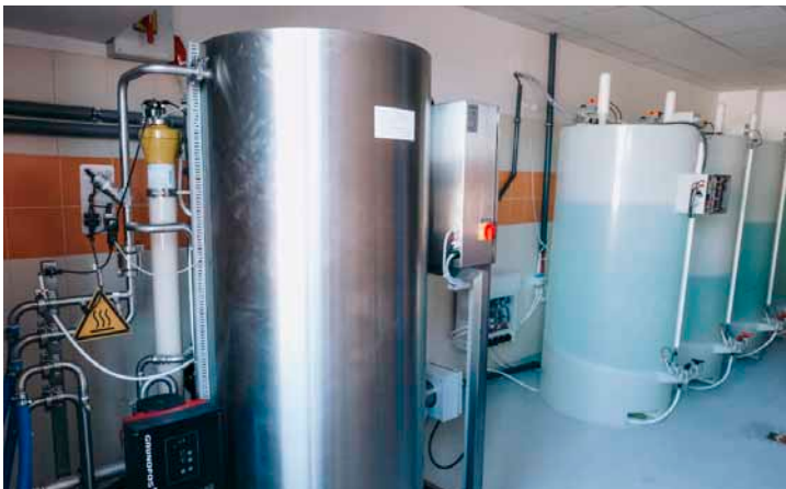
Přístroj pro horkou desinfekci, zásobní tanky pro dialyzační koncentráty / Foto: redakce
