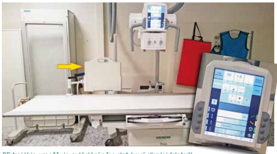
Přístroj Ysio umožňuje ovládání přes dotykový displej (detail) přímo u vyšetřovacího stolu. Šipka označuje přenosný digitální detektor.
