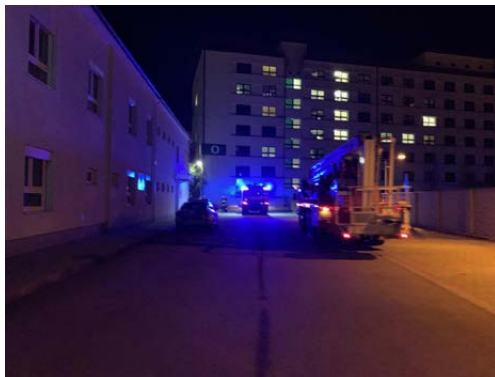
Hasičské vozy při požáru vzduchotechniky v pavilonu L | Foto: redakce
