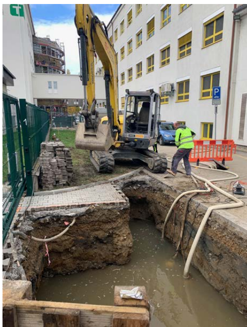
Havárie na vodovodním řádu | Foto: redakce
