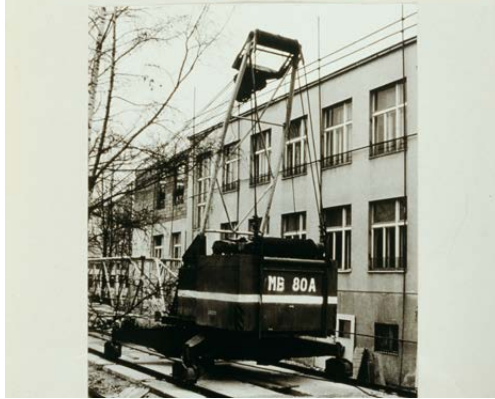
Začátek přestavby 1978 | Foto: archiv oddělení
