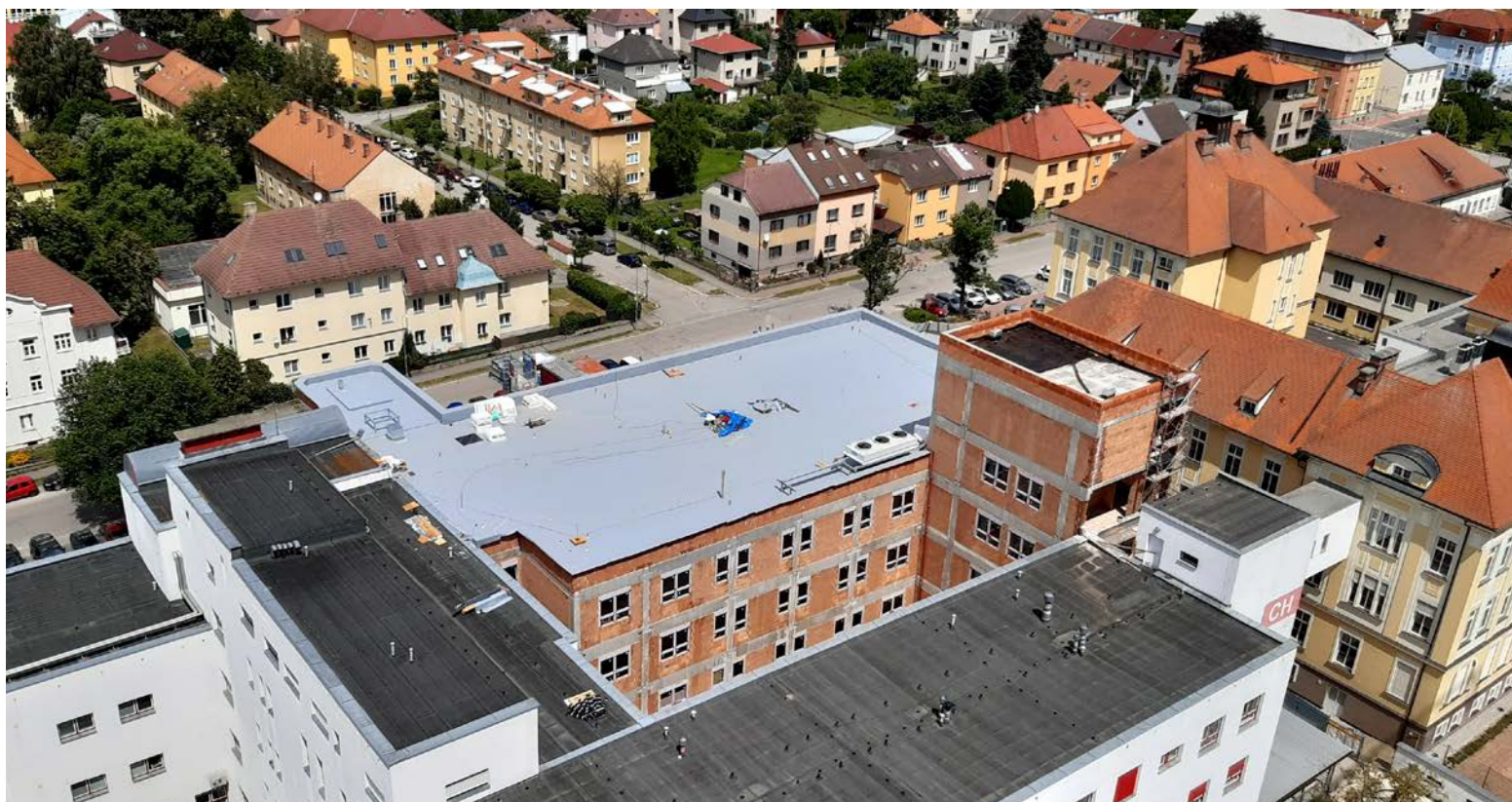
Pohled z jeřábu na objekt SO 08 „po dostavbě“
