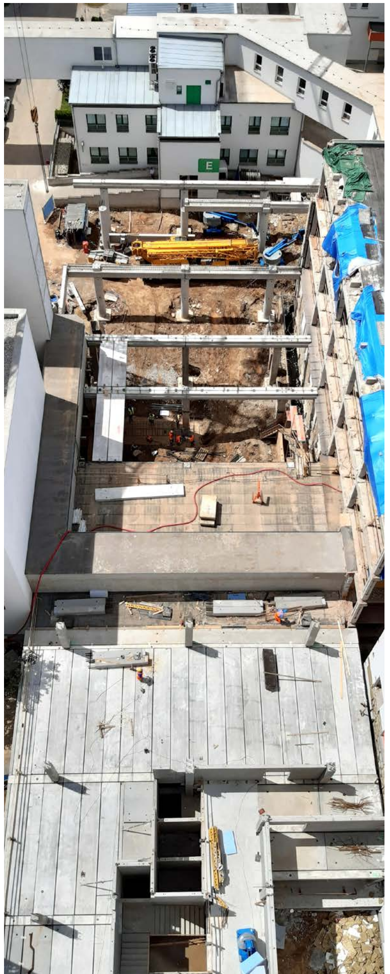
Výstavba nosného skeletu prefabrikované konstrukce. Je patrná spojovací chodba pavilonu CH se sousedním pavilonem Z
