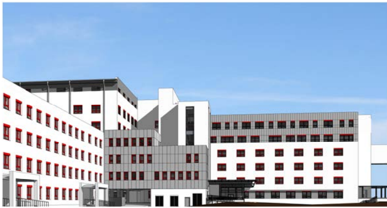
Jižní pohled na objekt SO 01 / SO 02 po dostavbě na cílový stav pavilonu chirurgie
