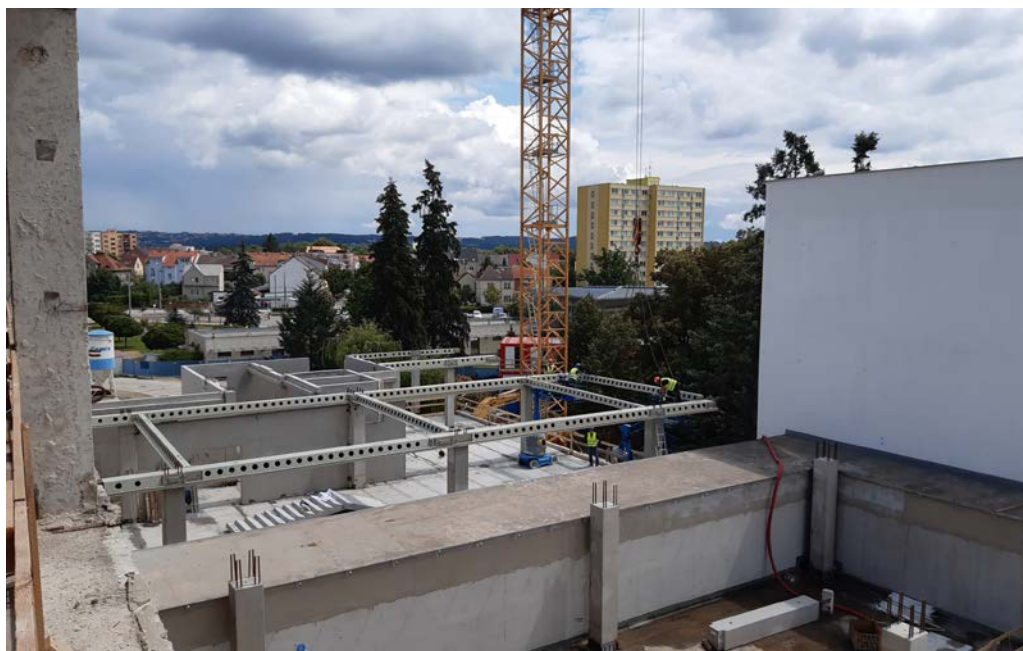
Pohled na prefa konstrukci s ocelovými nosníky před pokládkou panelů Spiroll
