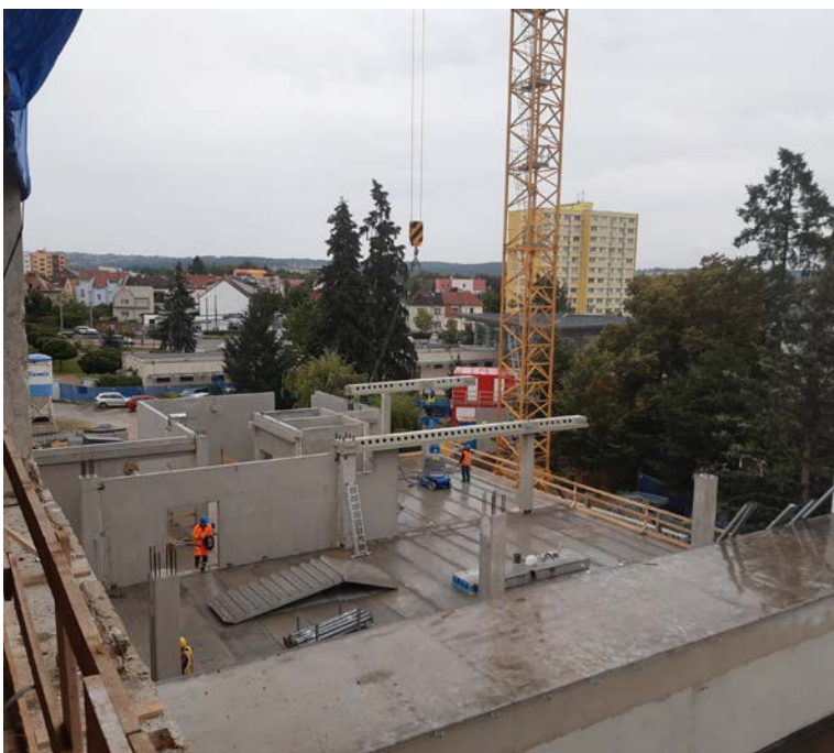
Výstavba nosného skeletu objektu SO 01 / SO 02, osazování ocelových nosníků
