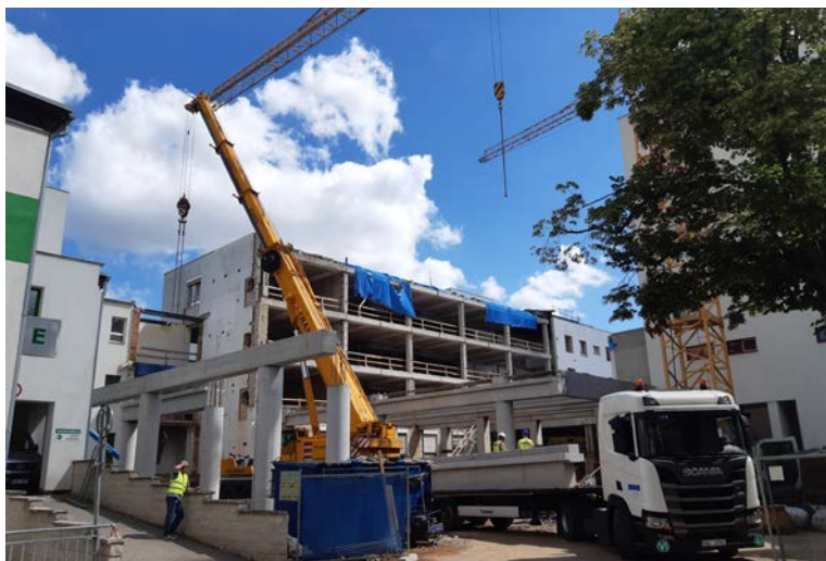
Západní část staveniště dotčeného výstavbou – provádění bouracích prací pro vestavbu a montáž prefa konstrukce. V lokacích nepříznivých z hlediska dosahu věžových jeřábů je nutno masivní konstrukční prvky osadit mobilním jeřábem
