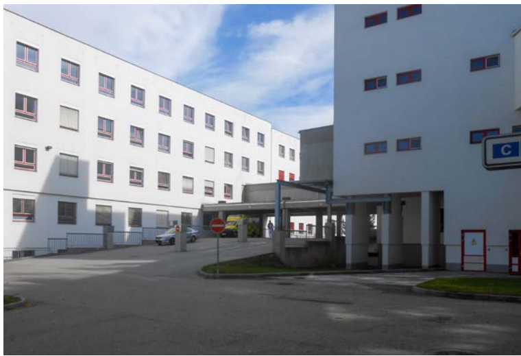
Prostor staveniště pavilonu CH před zahájením stavby
