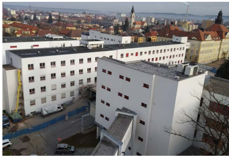
Objekty SO 01 a SO 02 – zahájení stavebních prací
