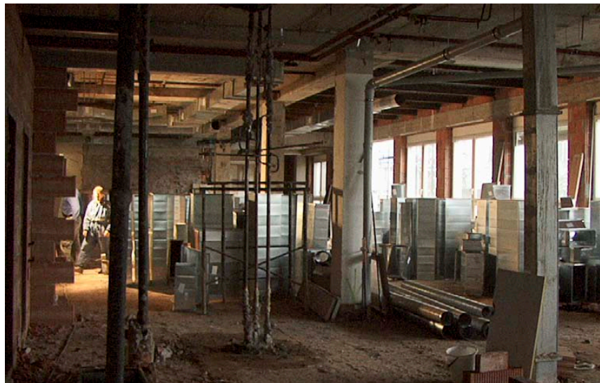
ARO RES v horním areálu v době rekonstrukce, 90. léta / Foto: archiv oddělení
