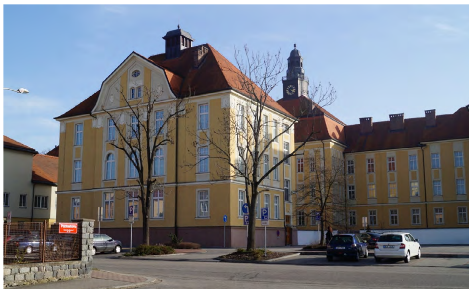
Zadní trakt historické budovy A, kde byla umístěna lůžková část oddělení
